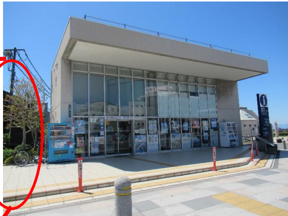
藤沢市観光センター建物外観
